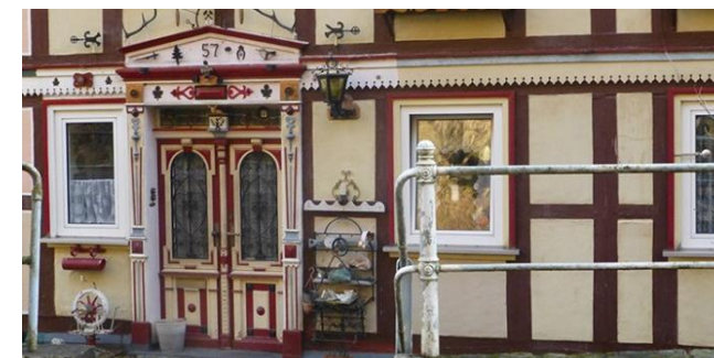
bauliches Detail, Haustür aus Sieber
