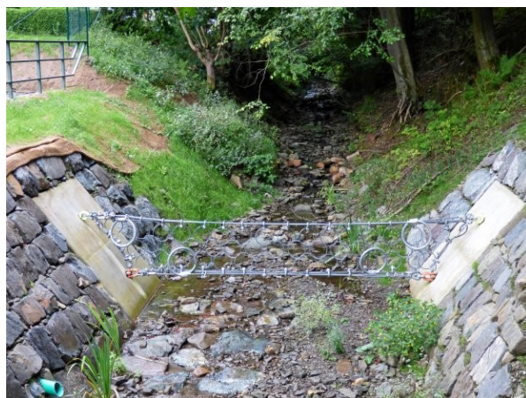
Die Wildholzsperrre in Lonau ist das bislang einzige derartige Bauwerk im Harz.
