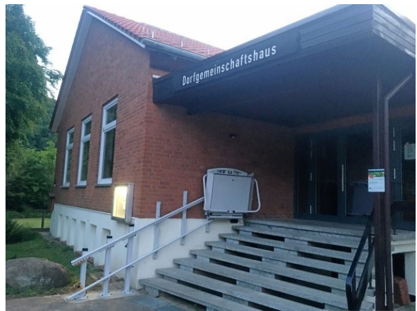
Neuer Treppenlift am DGH-Eingang.
